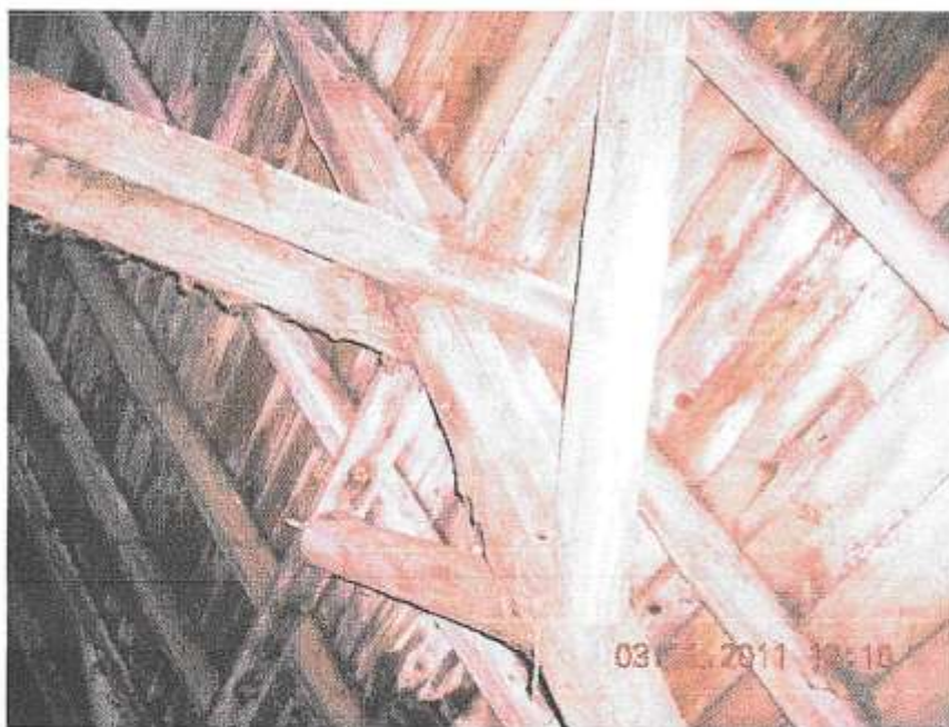
Fot.2 Węzeł więźby płatwiowo-kleszczowej obora Młynowo-P.Gnes
